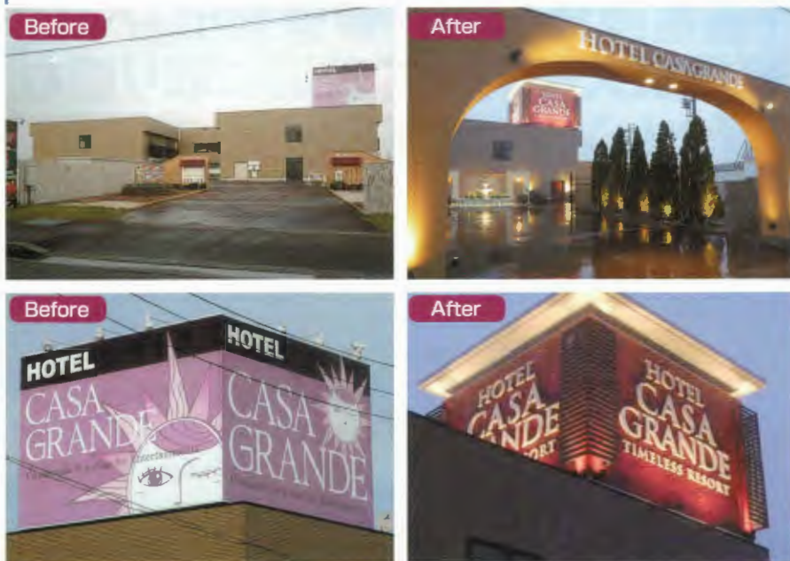
アーチ門、塔屋サイン、パームツリーの演出により外観イメージを一新。照明演出の見直しにより夜間の視認性も向上
